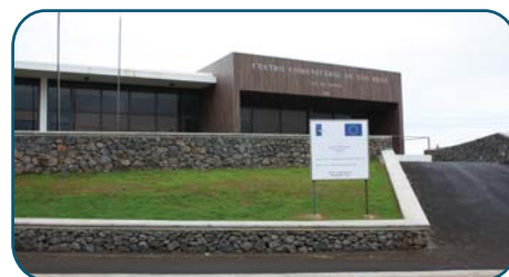
Construção do Lar de Idosos e Centro de Dia em São Brás
