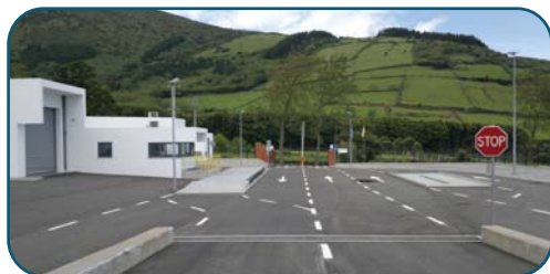
Centros de Processamento de Resíduos - Valorização Orgânica por Compostagem - Flores e Graciosa Custo Total Elegível 13.402.580,00€ Apoio comunitário 11.392.193,00€
