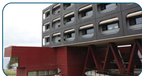
Construção Edifício Interdepartamental da Universidade dos Açores no Campus de Angra do Heroísmo
