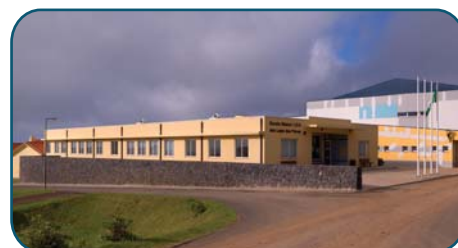
Construção da EB1,2/JI das Lajes das Flores
