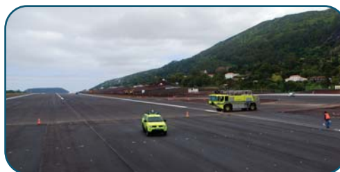
Ampliação e Alargamento da Pista do Aeroporto de São Jorge Custo Total Elegível 22.800.138,12€ Apoio comunitário 11.400.069,06€
